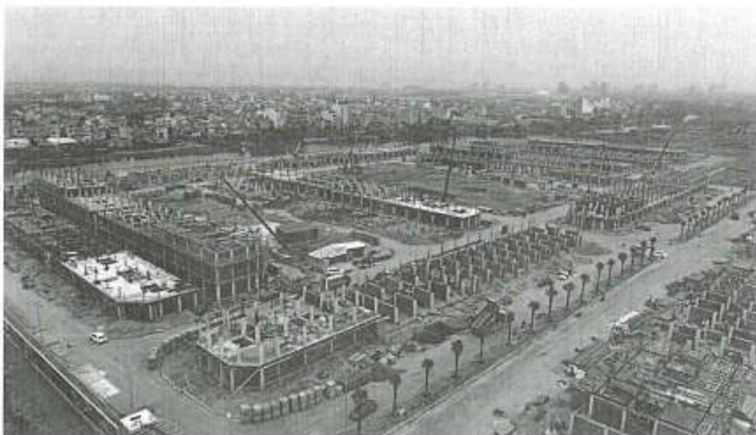
Cận cảnh tiến độ thi công các block nhà vào tháng 4/2025
