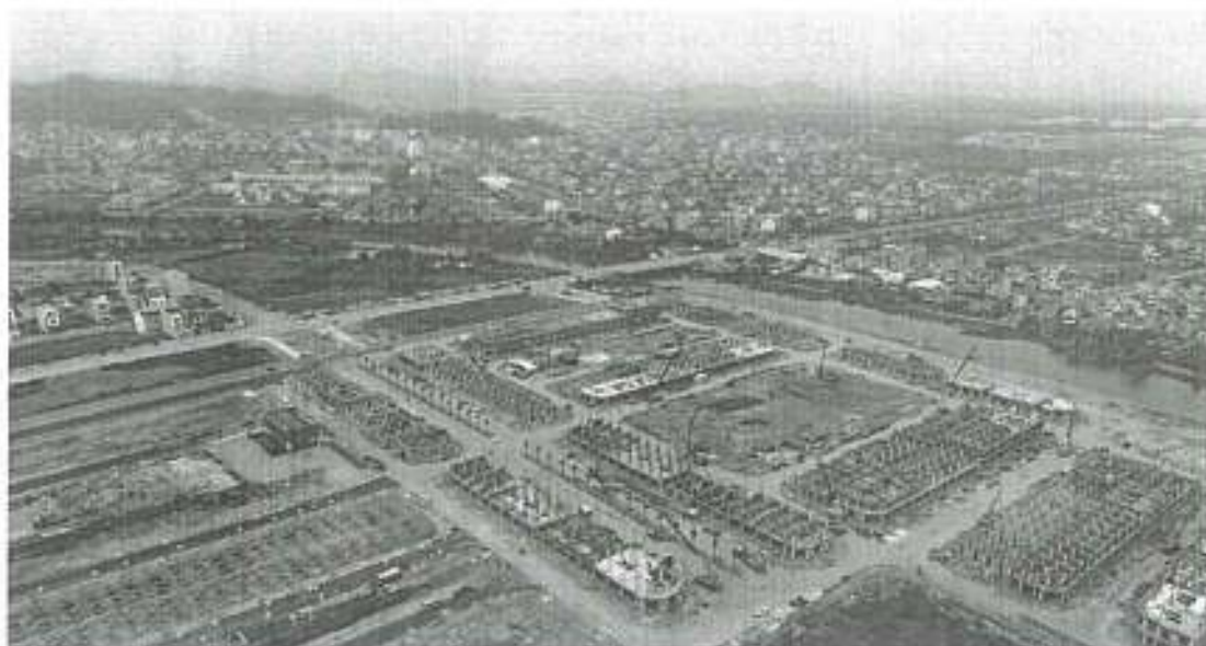
Dự án đang triển khai thi công đồng loạt, nhiều hàng mục nhà ở dần hình thành thời điểm đầu tháng 4/2025
